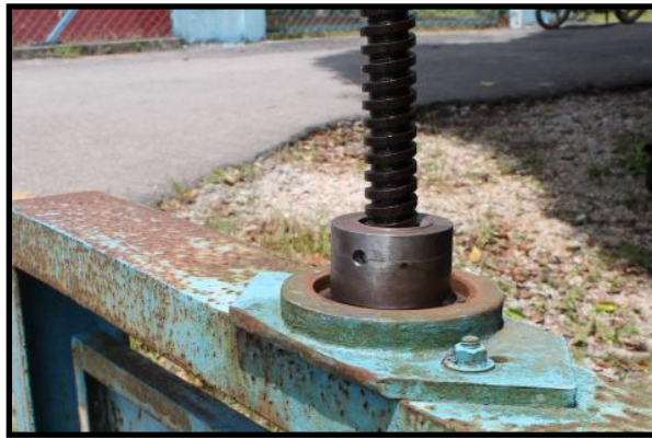
PASANG GATE LOCK STEERING DI SPINDLE THREAD SHAFT DI PINTU AIR
